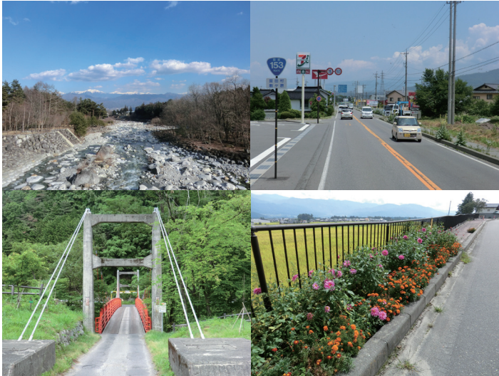
宮田村の重要な公共施設の例（左上から大田切川・国道 153 号・北の城橋・パノラマロード）
