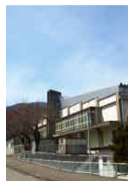
耐震工事が終わり外観もリニューアルした体育館
