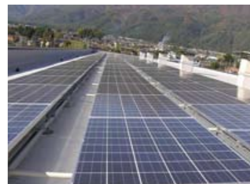
小学校に設置されている太陽光パネル
