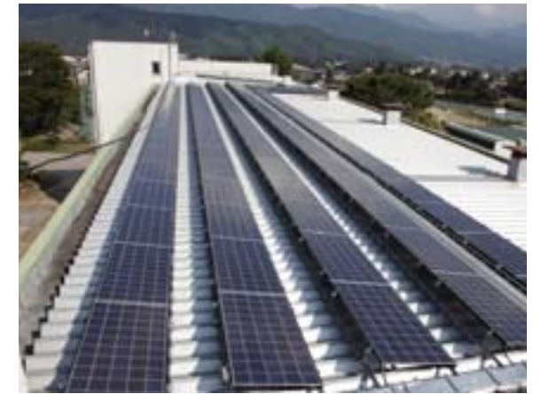
中学校に設置された太陽光パネル
