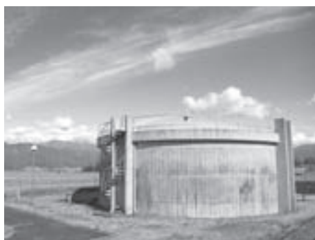
▲写真④ 第2配水池
