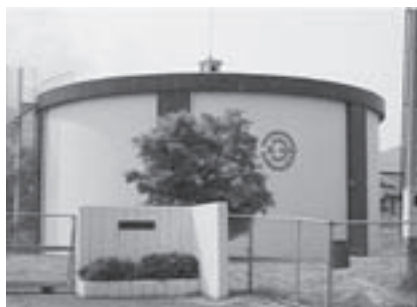
▲写真③ 調整槽
