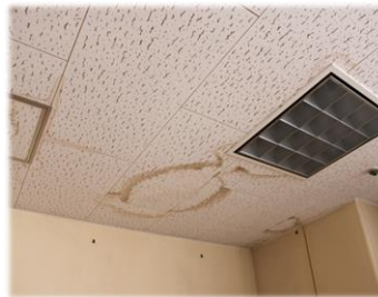
<雨漏りの跡が残る天井>
